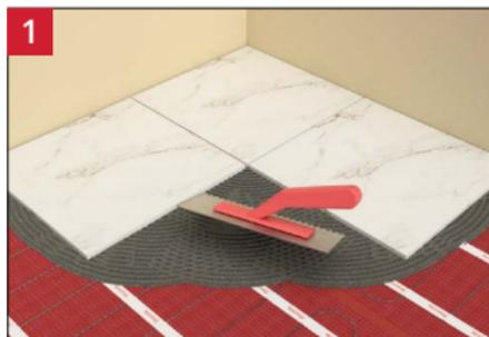
• Cubra a instalação com uma camada completa de cola para azulejos flexível usando uma espátula dentada. Tenha cuidado para não danificar ou desalojar o cabo de aquecimento. Se usar ladrilhos menores que 90 mm, cubra a instalação com um composto de nivelamento primeiro.
